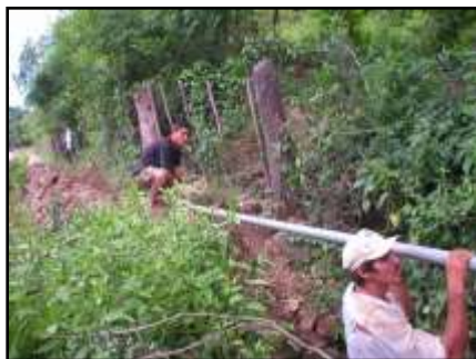
Travaux d'adduction d'eau
