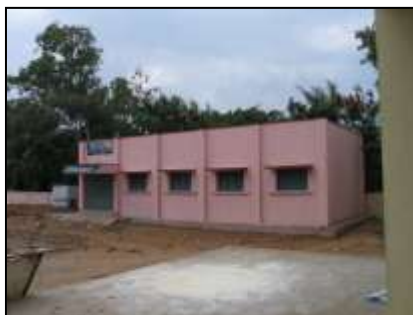
Salles de TP du collège en construction
