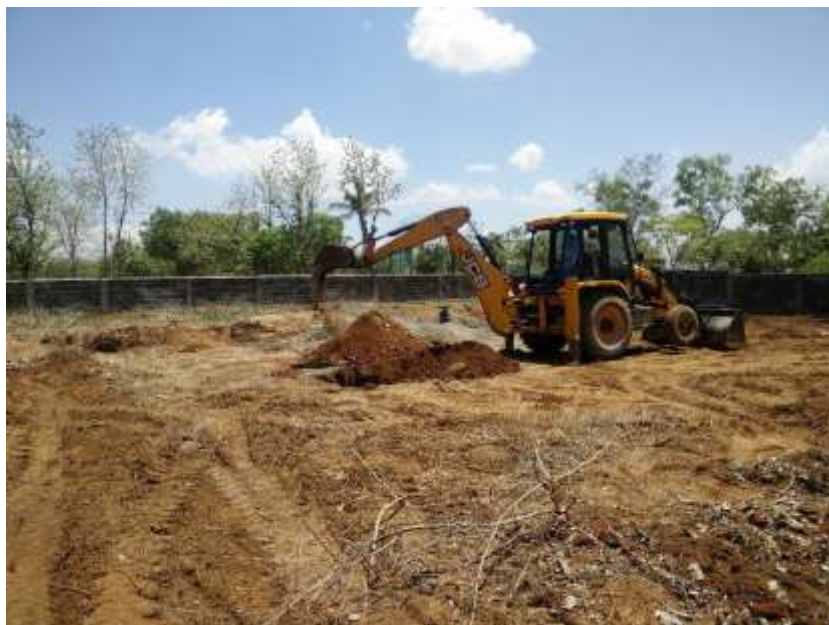
Mise à niveau et réalisation de l'étang de réserve
