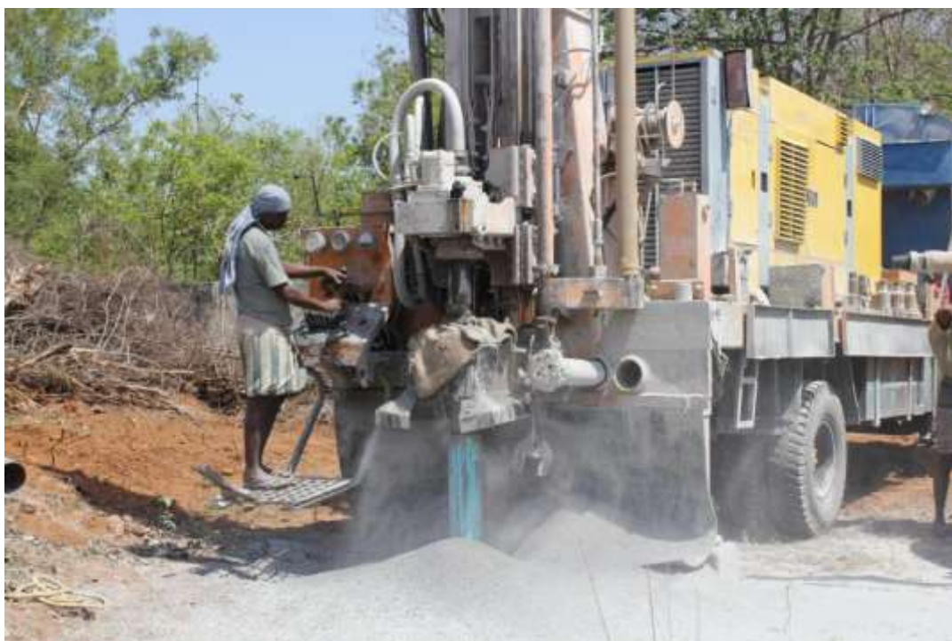
Forage du puits
